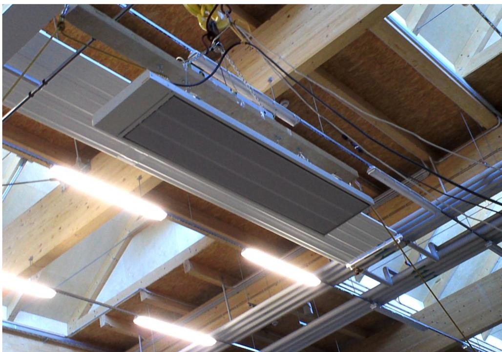
*Obr. 4-2 Panel Ecosun S+ 30 zavěšený na pomocné konstrukci v průběhu ustalování (pohled ze spodu)*
