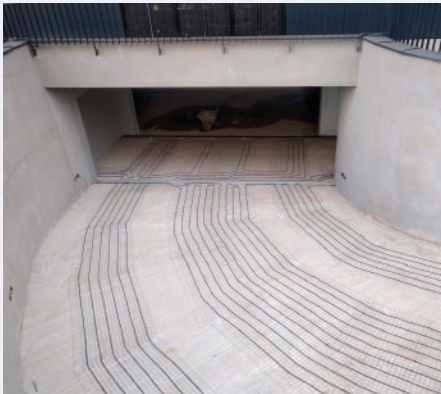
Vjezd do podzemní garáže, Záhřeb, Chorvatsko
